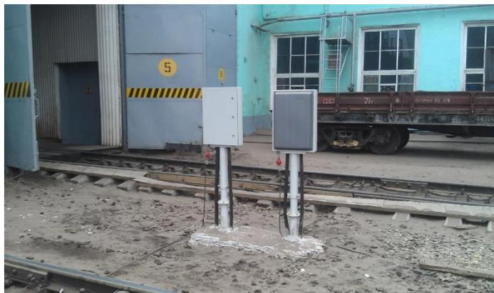
На инфраструктуре железных дорог располагаются пункты считывания малогабаритные (ПСЧМ). При прохождении подвижного состава мимо места расположения ПСЧМ срабатывают датчики прохода колеса, активирующие приемопередающее оборудование.
